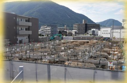
建物の基礎を作っています
