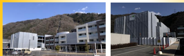
新施設の工事では現在、上階の床の施工と配筋、階数分の型枠工事を行いコンクリートを流し込んでいます。
